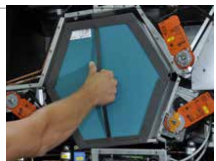
Abbildung: Gegenstromwärmetauscher
